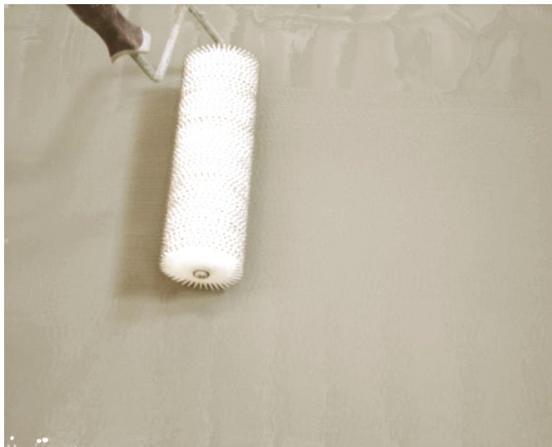
Rys 4 – Zastosowanie wałka do odpowietrzania w drugiej warstwie.
