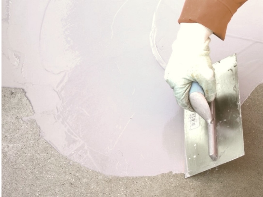
Rys 2 – Zacieranie na betonie.
